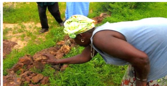
Construction des cordons pierreux par les femmes du village
